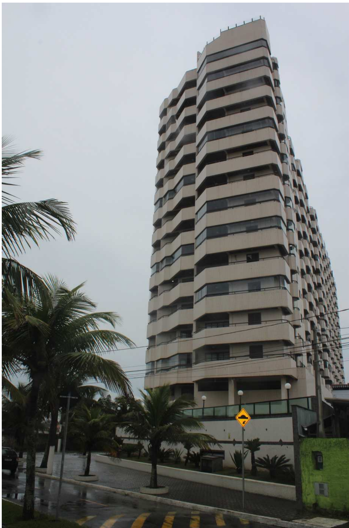
Condomínio Residencial Edifício Janete Mariano – Fachada
