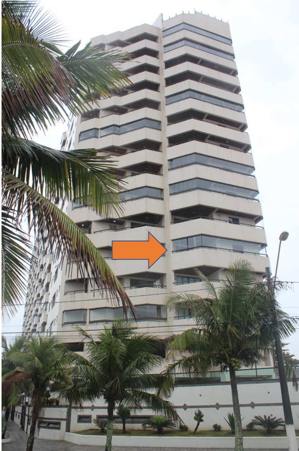
Situação Paradigma – Apartamento Nº 301 (Bloco “A”)
