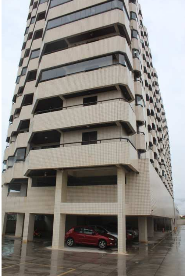
Condomínio Residencial Edifício Janete Mariano – Fachada
