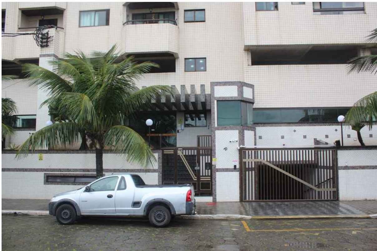
Condomínio Residencial Edifício Janete Mariano – Fachada
